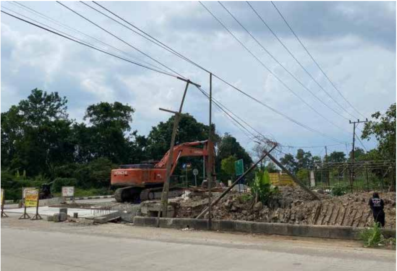
Pembangunan drainase di Jalan Diponegoro Kecamatan Tanjung Redeb.
