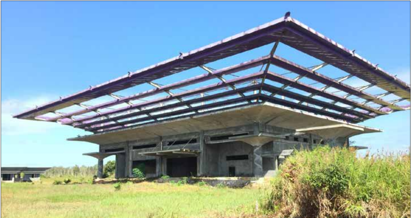
Kondisi pembangunan bandara
